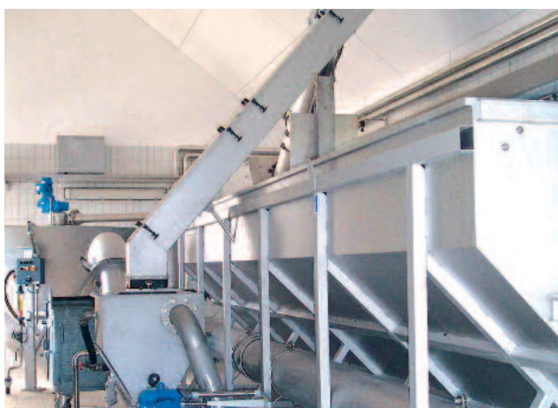
Intensiivne sõelmete pesemine WAP/SL pesupressis, mis järgneb ROTAMAT® terviklikule jaamale Ro 5
