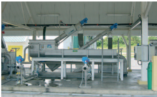
ROTAMAT® muda vastuvõtijaam õhutamata liivapüünise ja sisseehitatud liiva jaotuskruviga
