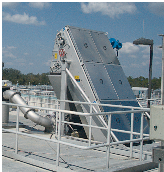
Täielikult suletud, lõhnava sõel kergesti eemaldatavate katetega
