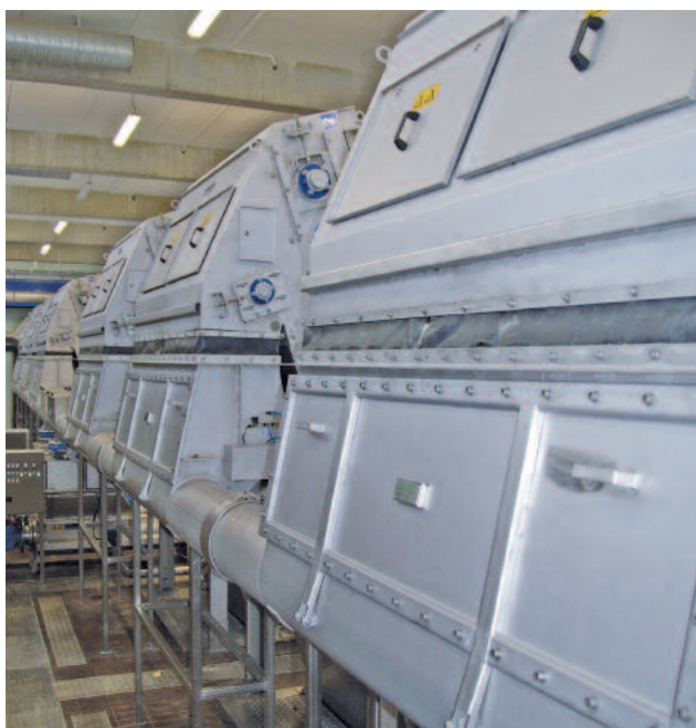
HUBERi lintsõela EscaMax® tagaosas vaade koos järgneva pesukanaliga kulumiskindlate sõelmete transpordi jaoks
